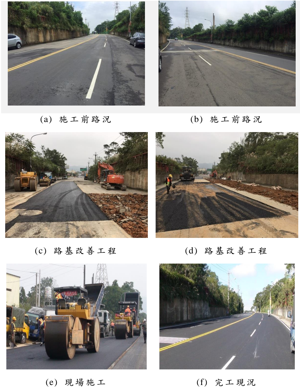
圖 7-3 桃 68-1 線道氧化矽瀝青混凝土試辦工程施工歷程 [9]
