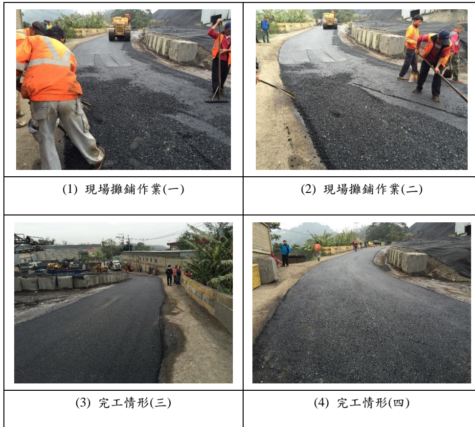
圖 7-7 氧化矽瀝青混凝土鋪面試鋪情況(廠內試鋪) [10]
